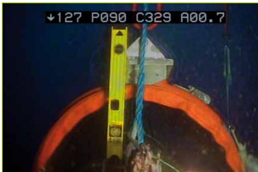
La mise en place du coffrage par 90 m de profondeur
